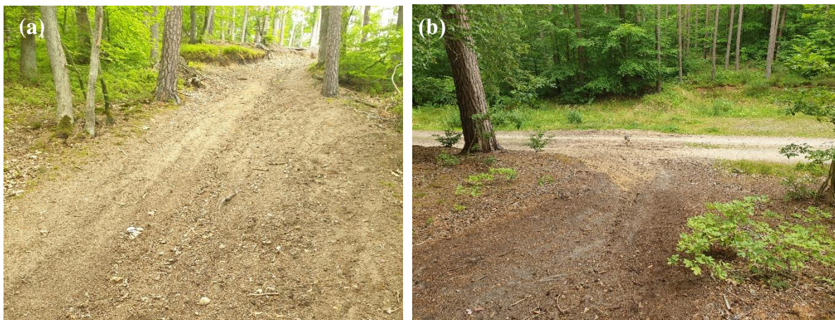
Rysunek 4 dzikie zejście z widoczną erozją gruntu (a); odsypisko gruntu na drodze (b)
