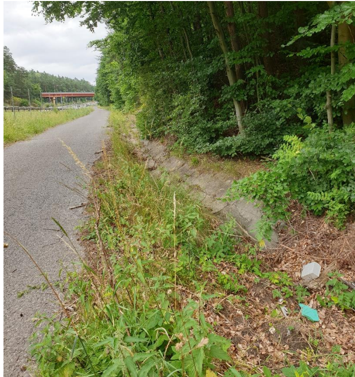
Rysunek 6. Rów odprowadzający wodę z górnej części zlewni potoku Demptowskiego (A4 i A5); widoczne zakończenie rowu kierujące wodę do zlewni leśnej A2; w tyle widoczny wiadukt trasy Kwiatkowskiego nad obwodnica trójmiejską.
